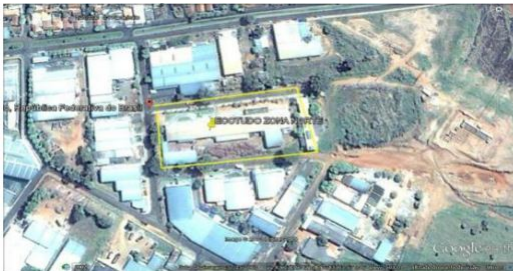
Figura 10: Vista aérea – Ecotudo Zona Norte. Fonte: GOOGLE MAPS
