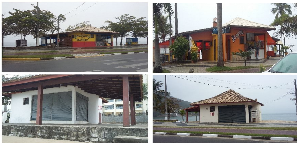
Figura 5— Quiosques aonde foram instaladas as bituqueiras. Fonte: A autora, 2016. (Acervo pessoal)
