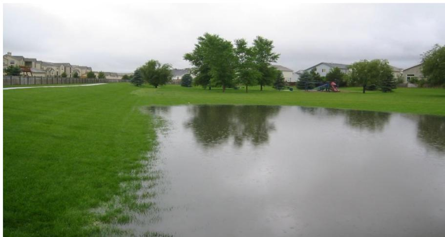
**Figura 4: Planos de infiltração com áreas submersas**
