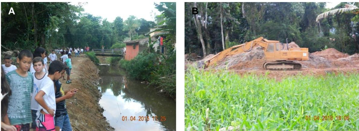
**Figura 9A e B:** Alteração do Canal do Rio da Lagoa, Ubatuba-SP. A: leito do rio com erosão, B: máquina acelerando processo erosivo.
