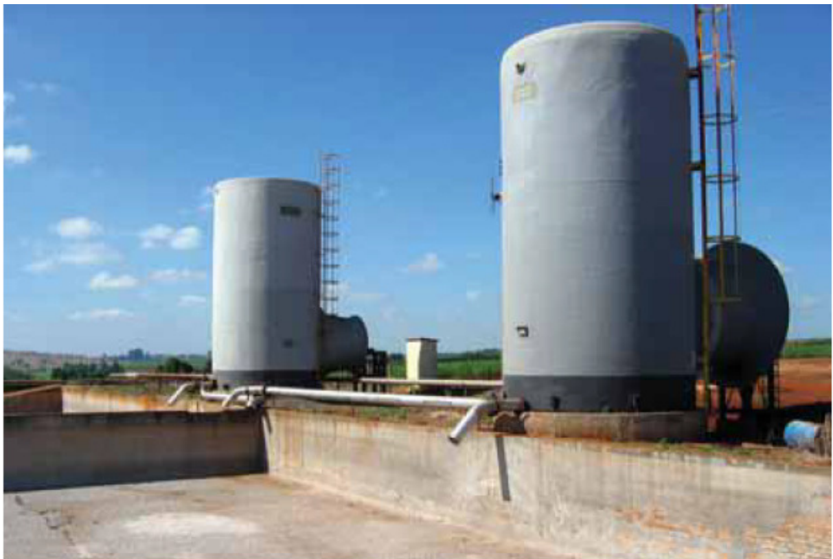
Figura 1 Tanque mestre para recebimento e distribuição de vinhaça. Fonte: ANA, 2009.
