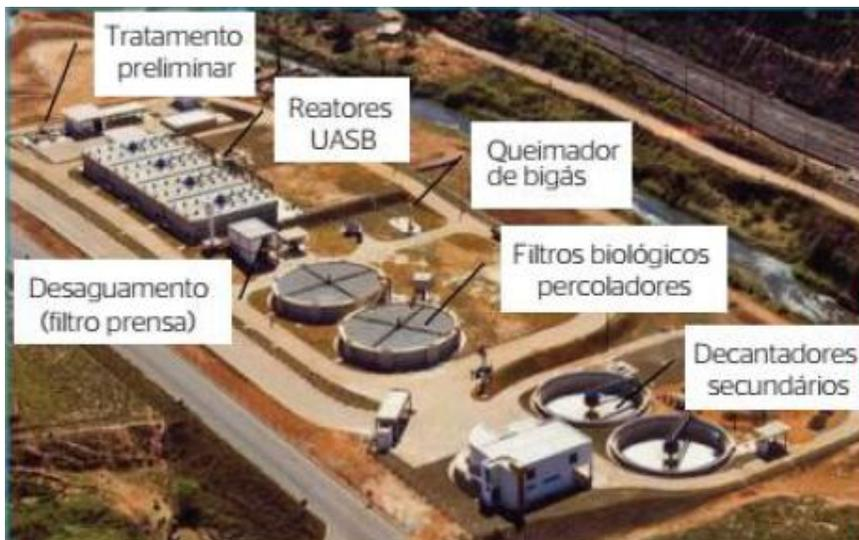
**Figura 19:** Vista geral das unidades da estação de tratamento de esgoto Laboreaux
